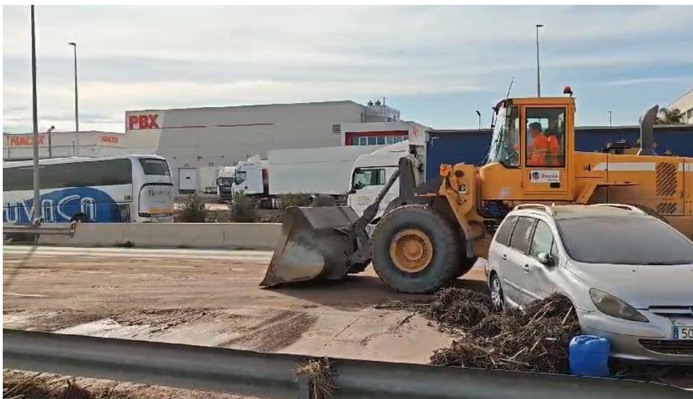
Primero trabajos de limpieza en la A-3 (Valencia)
