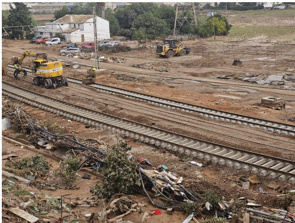
Trabajos de limpieza en el tramo común de la C1 y C2 de Cercanías de Valencia
